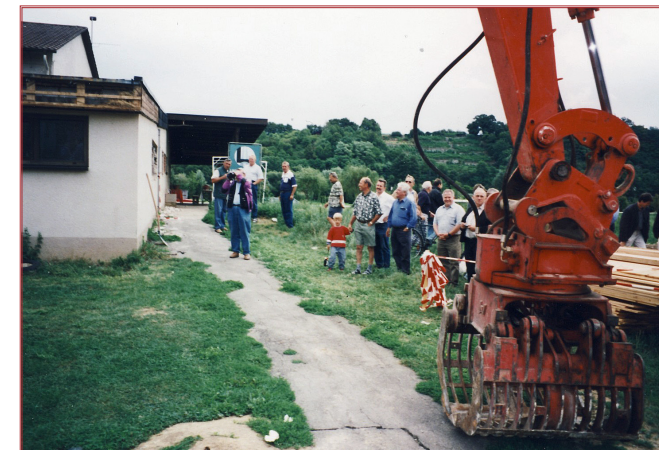
Bilder vom Baggerbiss
