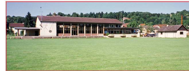
Die alte Halle vor dem Abriss
