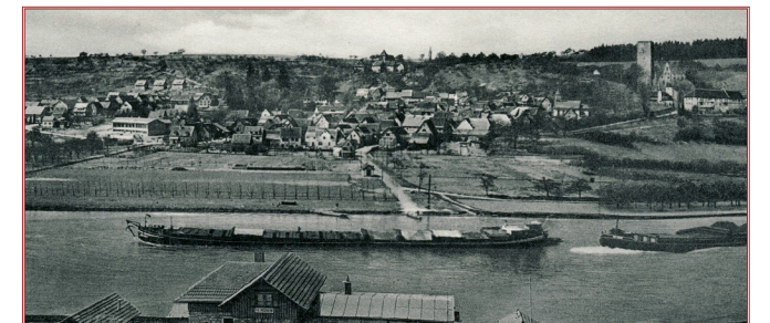
Sportgelände 1956 mit den bereits sichtbaren Fundamenten der Turnhalle und frischer Pappelbepflanzung
